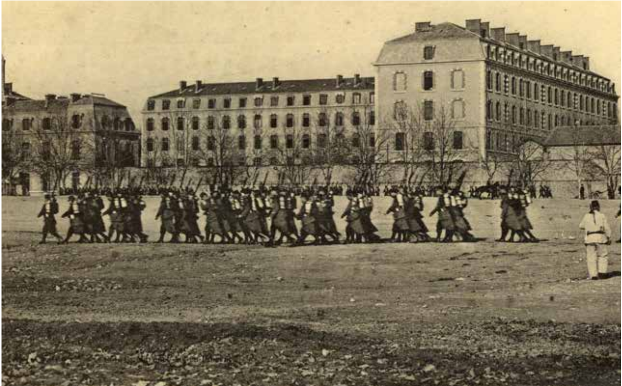
Vue du quartier MIOLLIS depuis le quartier RUIBET (LMA 1900)
